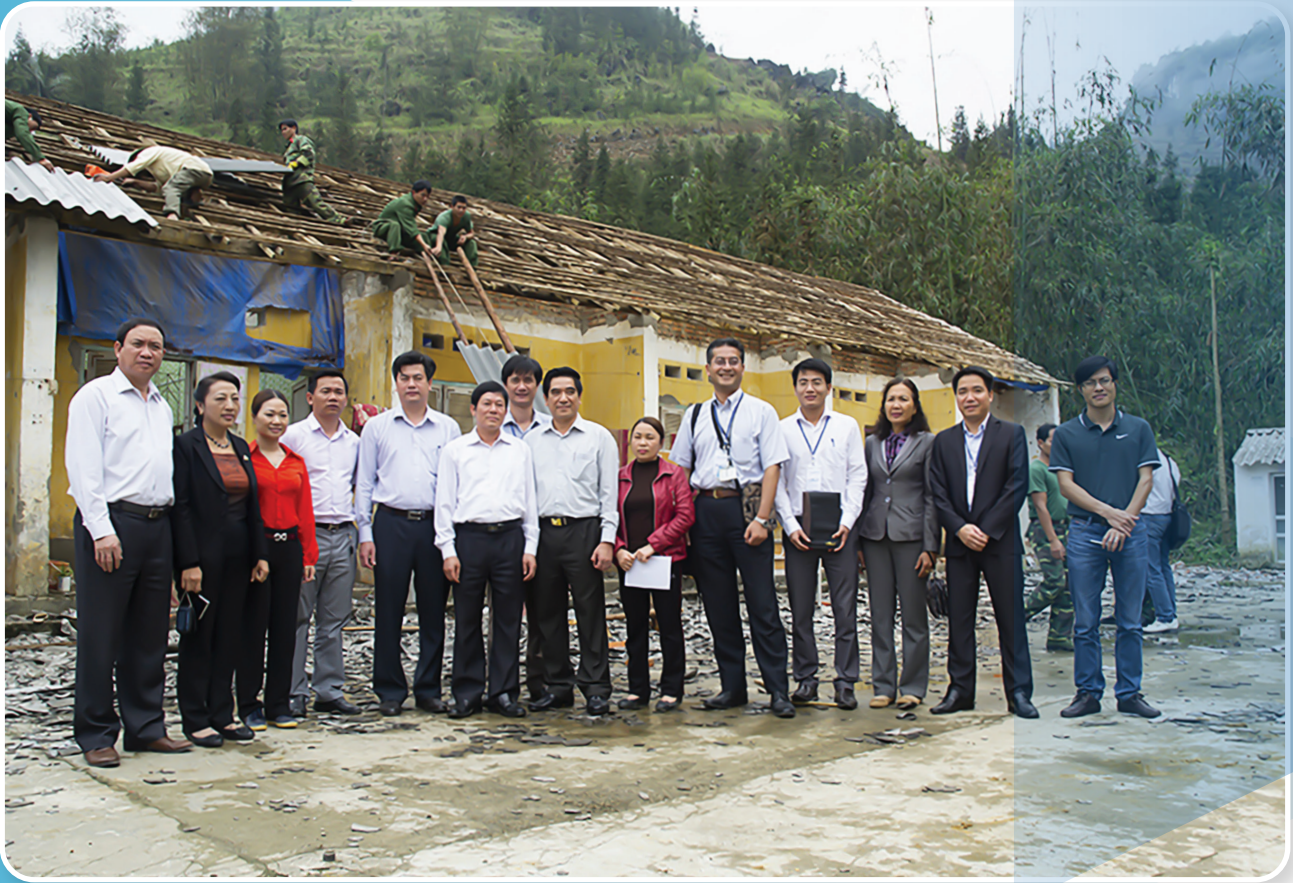
TÀI TRỢ MÁI LỢP ĐIỂM TRƯỜNG TẠI LÀO CAI | SPONSOR THE ROOFING OF A SCHOOL IN LAO CAI
